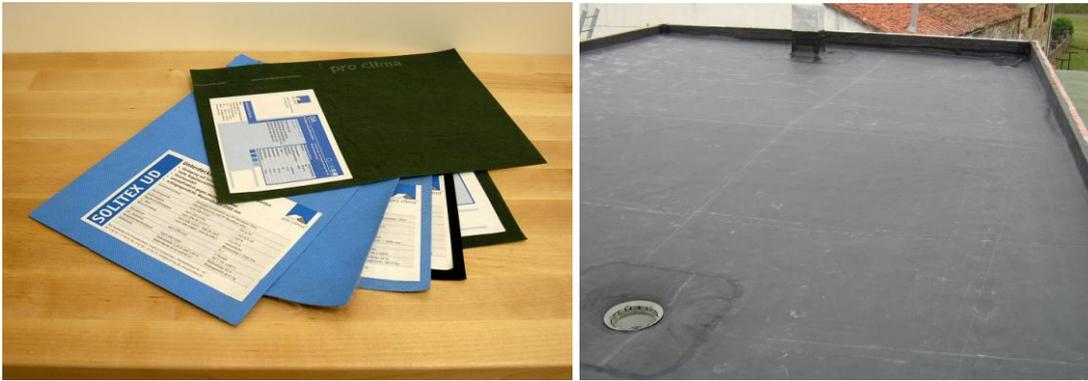
Lámina de caucho E.P.D.M. para impermeabilizar cubiertas vegetales
