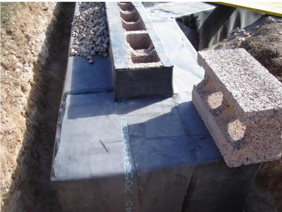
Sistema para impermeabilización de cimentación con membrana de caucho.
