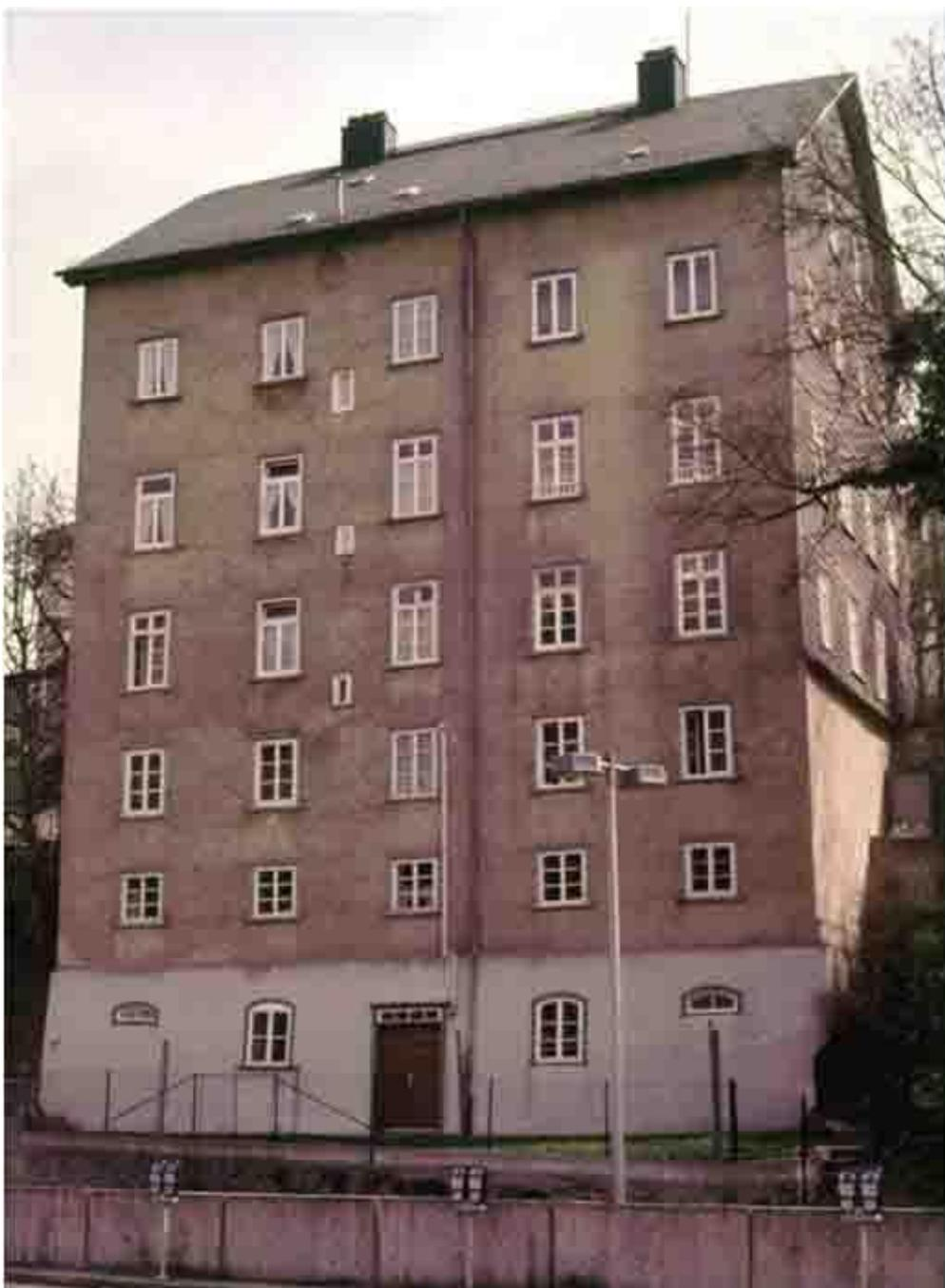
Edificio en Alemania construido con tierra y técnicas mixtas de tierra con otros materiales.
