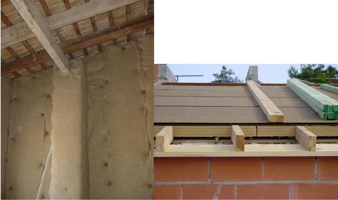
Sistema para aislamiento de cáñamo en interior y de fibra de madera en exterior (cubierta).
